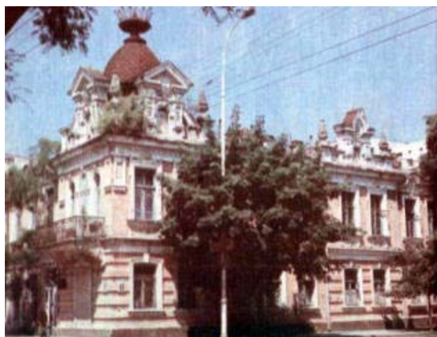
Здание на углу ул. Ворошилова и Красноармейской, 69/39. В прошлом гостиница Е. Ф. Губкиной «Гранд-отель», построена в конце XIX в.
