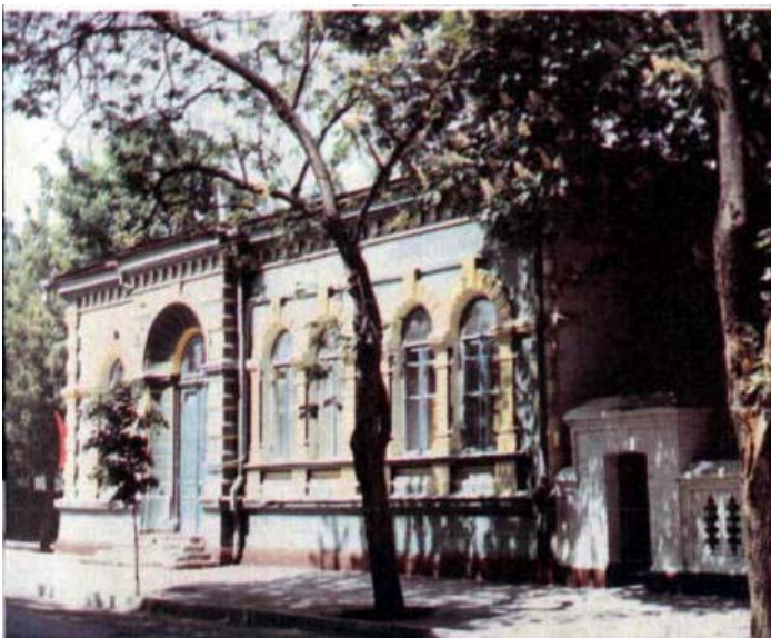
Здание на углу ул. Гоголя и Янковского, 92 /30. В прошлом доходный дом барона Л. В. Штеингеля, построенный в 1905 г. Затем владельцами его были генерал А. И. Кияшко, предприниматель А. И. Шаповалов. До революции здесь размещалась аптека провизора Явелова. Ныне аптека № 8
