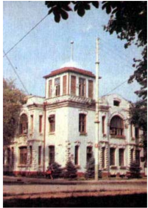
Здание на углу ул. Комсомольской и Шаумяна, 41/18. В прошлом жилой дом купца В. С. Сокольского постройки конца XIX в.
