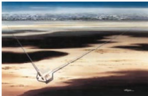
**Рис. 5.** Проект лазерного интерферометра LIGO, строящегося в США под Ливингстоном (штат Луизиана) и в Хэнфорде (штат Вашингтон) с целью детектирования гравитационных волн. Лазерный луч направляется по двум перпендикулярным направлениям (плечам), на концах которых расположены зеркала. После отражения лучи возвращаются к вершине и смешиваются
